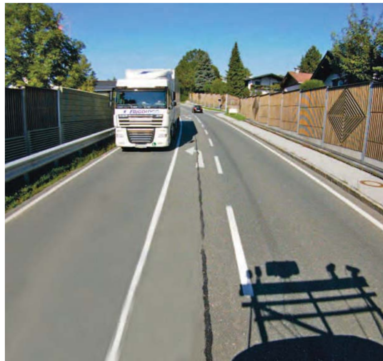
Siedlungen und Verkehrswege auf engstem Raum. Schutzwände reduzieren zwar die Lärmbelastigung, die Trennwirkung der Straße wird jedoch erhöht.
